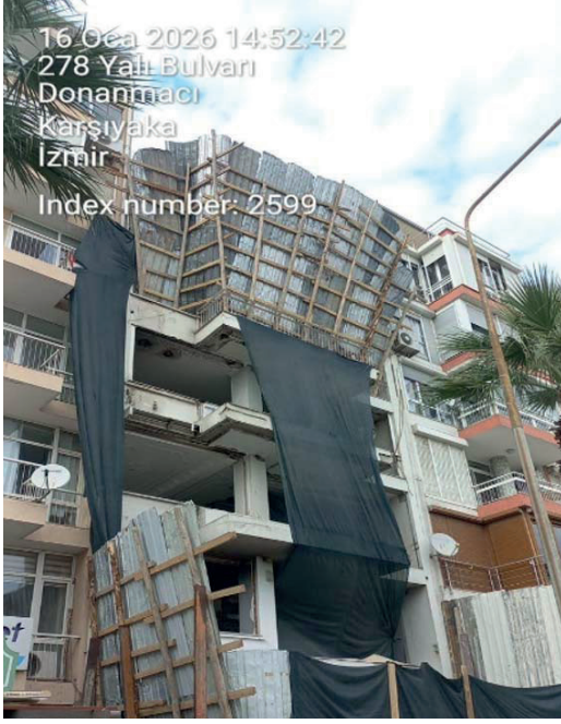
Yıkım Öncesi Önlemler
