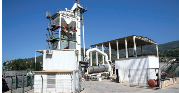
Asfalt Üretim Tesisi Kilit Parke Üretim Tesisi
