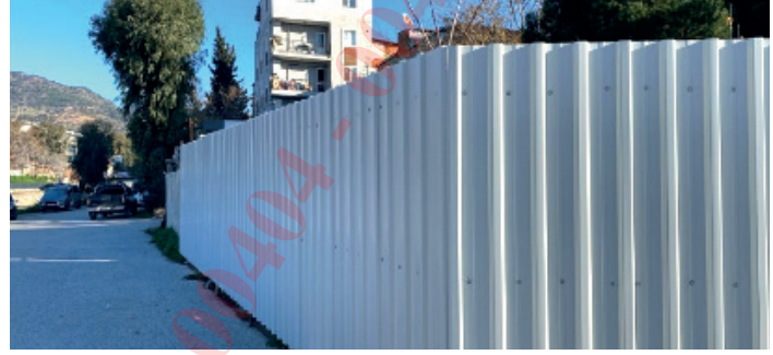
Yıkım Aşaması Ve Sonrası Güvenlik Önlemleri
