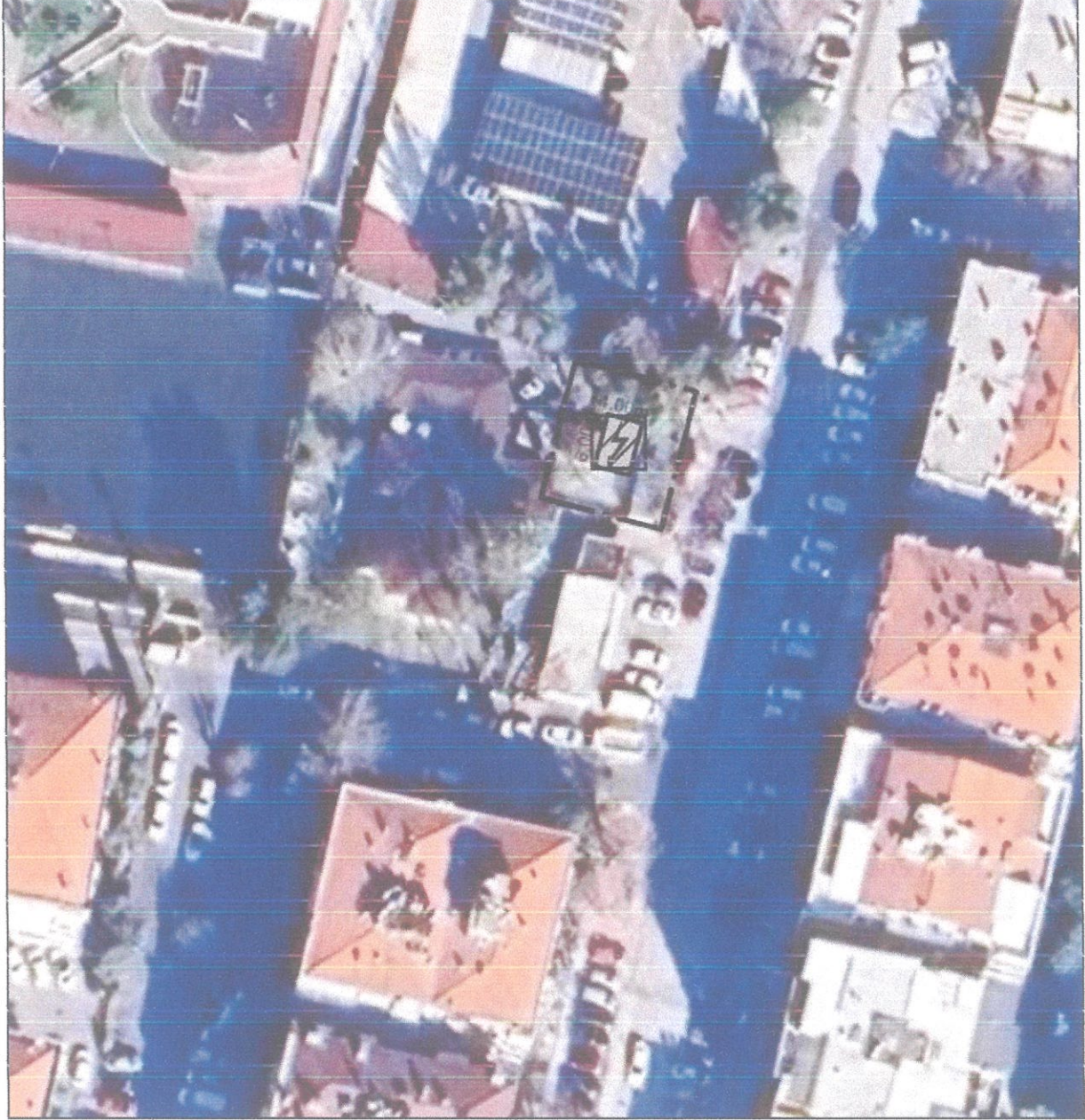
-Trafo Alanının Uydu Görüntüsündeki Konumu-
