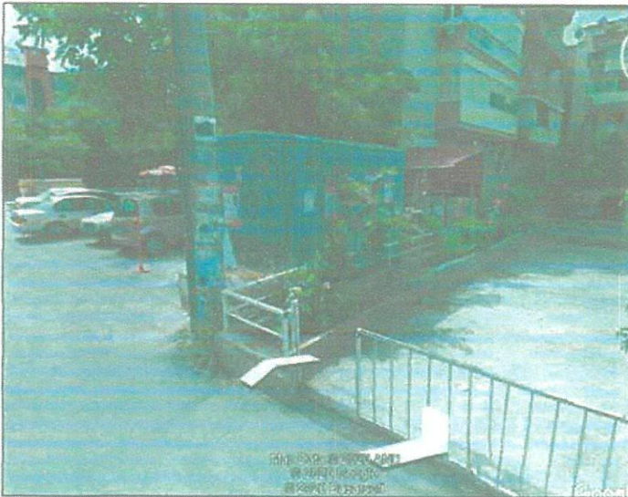
Resim 51: 15 nolu trafo alanı
