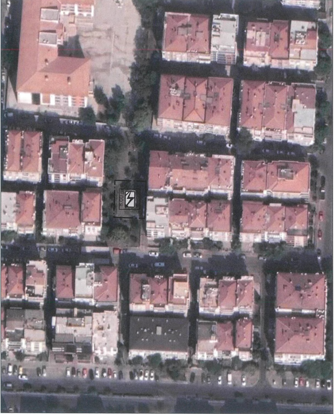
-Trafo Alanının Uydu Görüntüsündeki Konumu-
