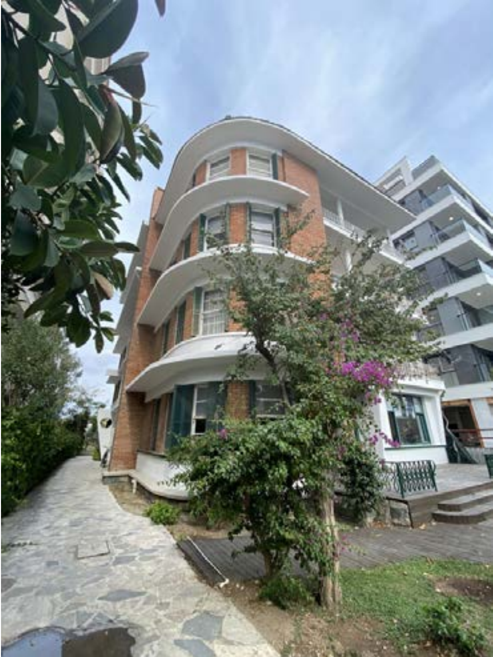
Foto.21: Paya Apartmanı ( https://izmirkentbellegi.yasar.edu.tr/paya-apartmani/paya-apartma-
