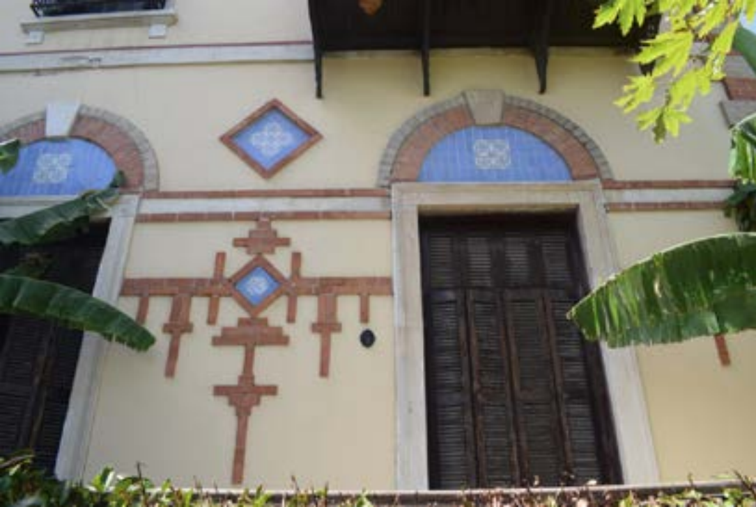
Foto. 17: Löhner Köşkü güney cephesi tuğla ve çini süslemeler
