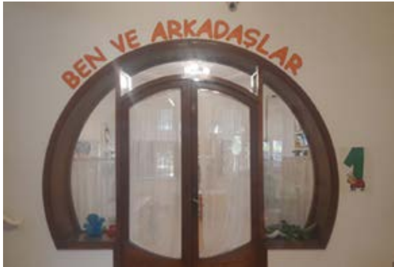
Foto. 11: Penetti Köşkü ahşap kapı
